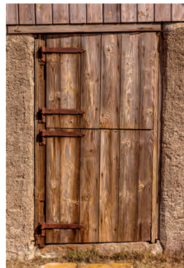
Förhindra rost /korrosion
